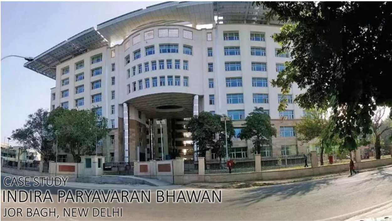
تصویر (۱) ساختمان Indira Paryavaran Bhawan در دهلی نو
